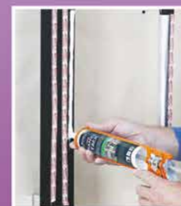
Paso 4: Aplicar el adhesivo
