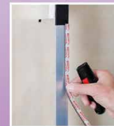
Paso 3: Colocar la cinta Foam Tape
